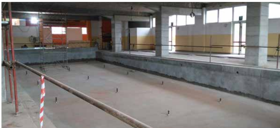
Lavori di ristrutturazione, 2018/19.
