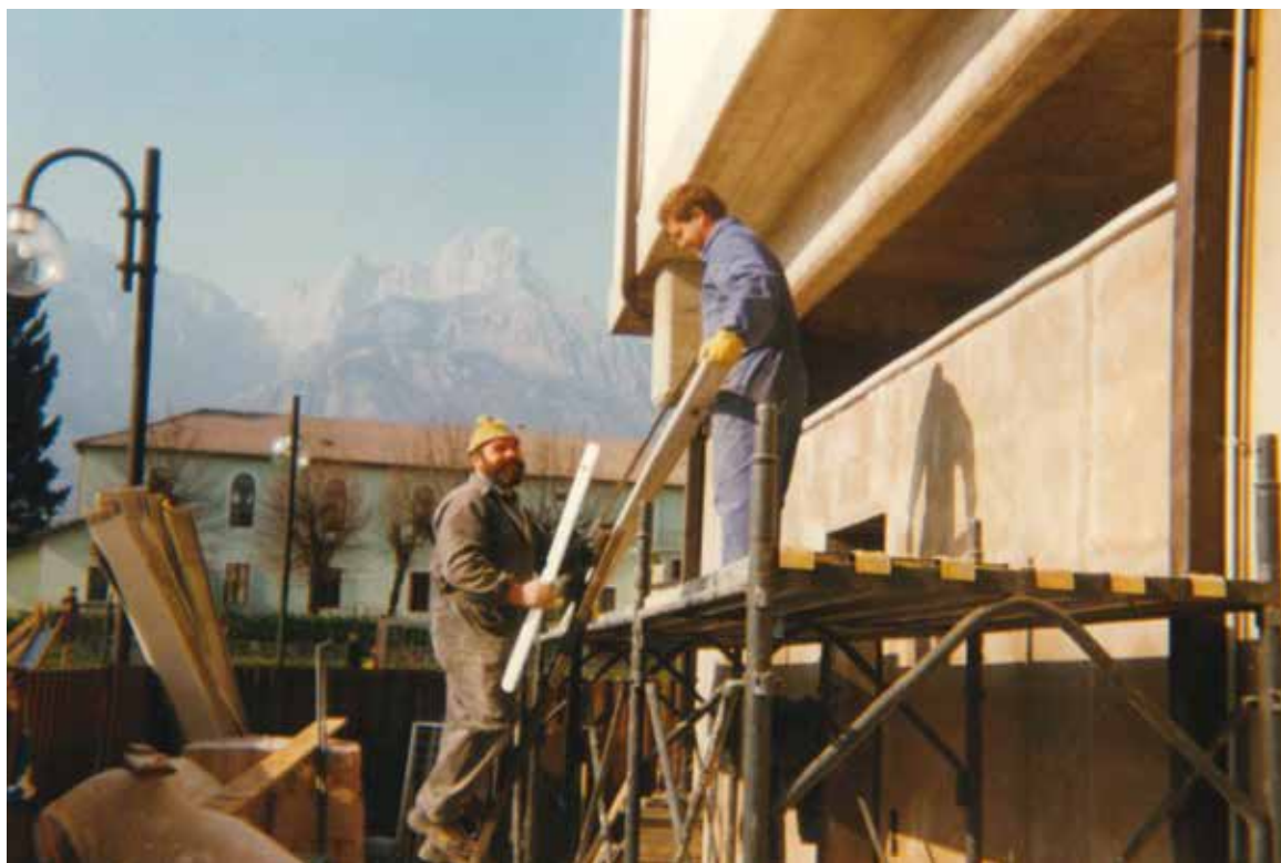
Inizio lavori primi spogliatoi disabili, 1999.
